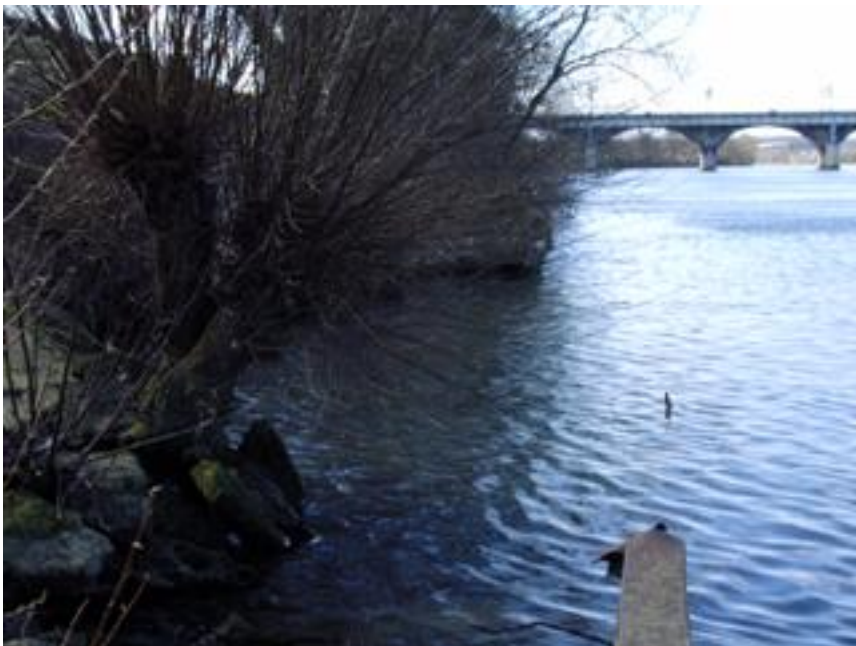
(11) fév2008 « Tectonique » des grosses poutrelles
