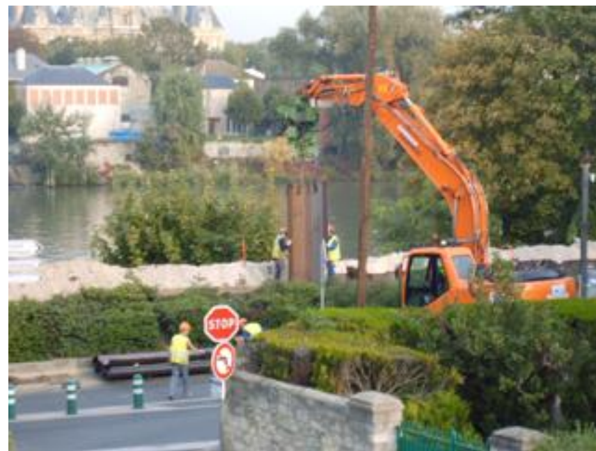
(16) oct2006 battage des palplanches entre les 2 ponts
