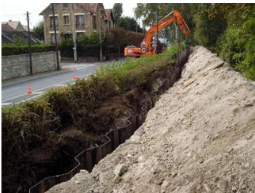
(15) oct2006 battage des palplanches entre les 2 ponts
