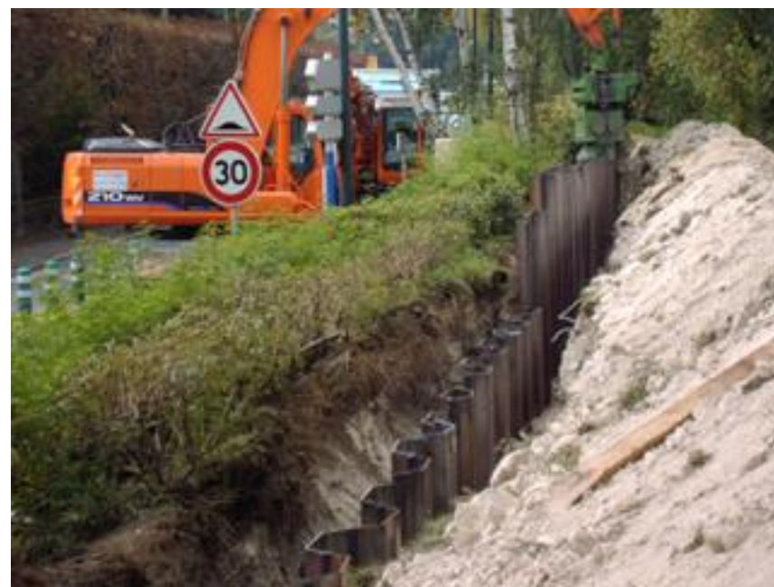
(17) oct2006 battage des palplanches entre les 2 ponts
