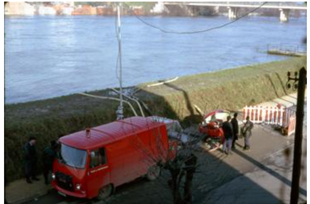
(1) janv1968 1ere crue digue neuve
