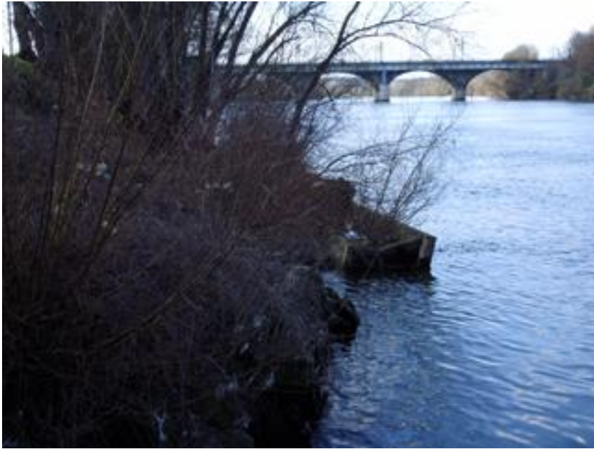
(10) fév2008 « Tectonique » des grosses poutrelles
