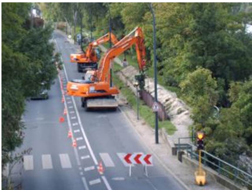
(14) oct2006 battage des palplanches entre les 2 ponts
